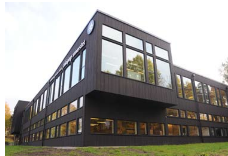
FASADEN PÅ DEN NYBYGGDA CARL MALMSTEN-SKOLAN ÄR EN VACKER TRÅPANEL SOM ÄR MÅLAD I EN SVART MATT FÄRG.
