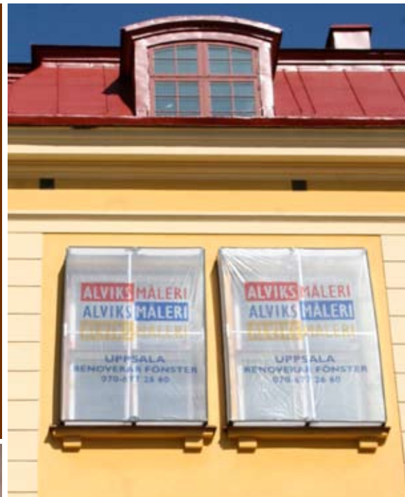
HÄR HAR FÖNSTER PLOCKATS NER FÖR ATT MÅLAS OM I VERKSTAD. FÖNSTERSKYDDEN I KANALPLAST HAR LJUSINSLÄPP OCH EN VÄRMEISOLERANDE EFFEKT.
