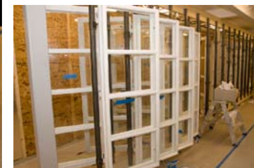
6... OCH SLUTLIGEN HÄNGS FÖNSTERBÅGARNAS UPP FÖR MÅLNING.
