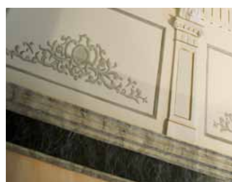
MOTIVET I VÄGGSPEGLARNA HÄMTADE ARKITEKTEN FRÅN DÖRRÖVERSTYCKENA. DET MÅLADES SEDAN I GRÅTT AV DEKORATIONSMÅLARNÄ.
