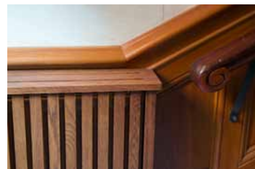
RADIATORSKYDD TILLVERKADES I EK OCH BETSADES I SAMMA KULÖR SOM SNICKERIENA.
