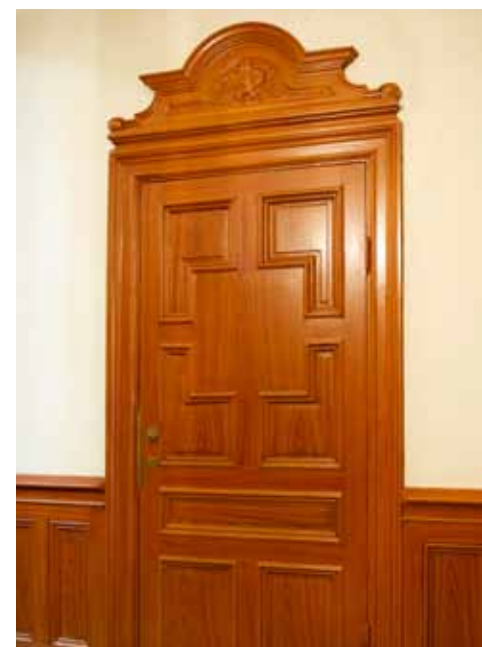
DÖRRAR OCH SNICKERIER ÅDRINGSMÅLADES I EN RÖDBRUN KULÖR.
