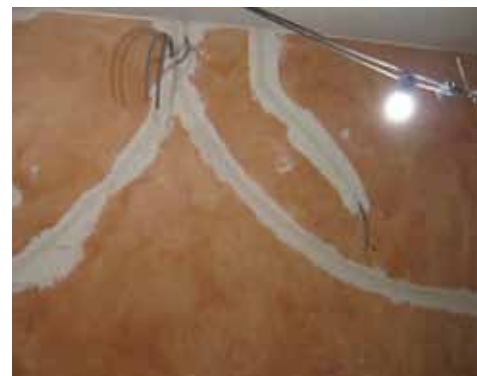
FÖR ATT SLIPPA SYNLIKA ELLEDNINGAR SPÅRADES ALL EL IN I VÄGGEN INNAN OMMÅLNING.
