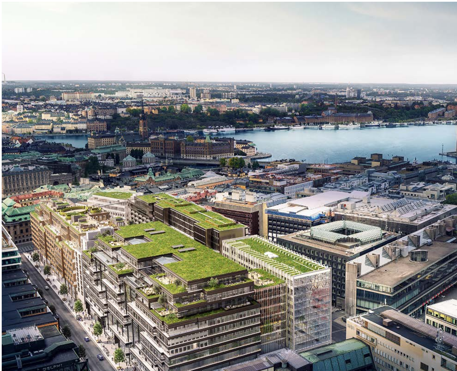
PROJEKTET URBAN ESCAPE ÄR GIGANTISKT: 100 000 KVM KONTOR, HOTELL OCH KONFERENS, 38 000 KVM HANDEL OCH 2 000 KVM BOSTÄDER.
